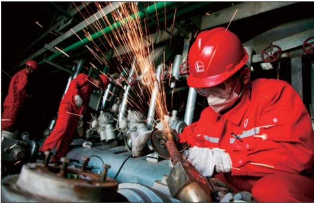
员工在五号注汽站小修中更换高压阀门。
