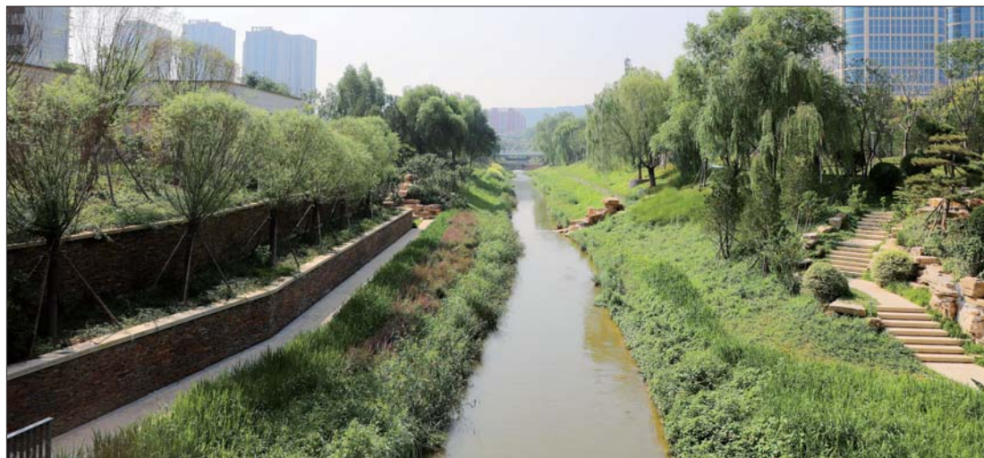
腊山河沿线雨污合流管网改造补水工程,是槐荫区建设生态景观,节约绿化浇洒的典型案列。
