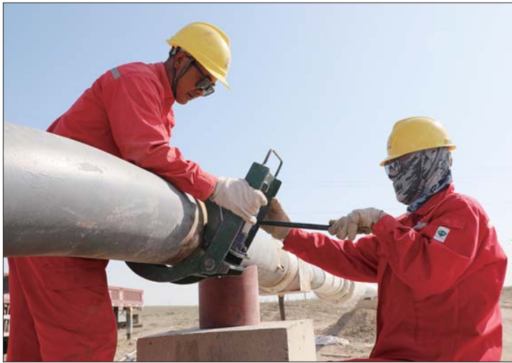
新春公司加快地面工程建设进度。
