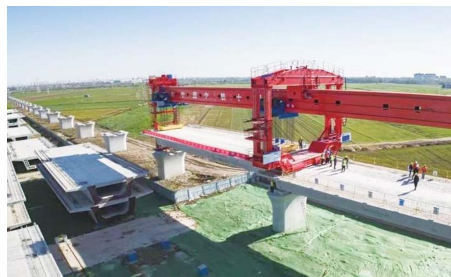
其他传统结构形式的架桥机,架设效率高出20%—30%。
