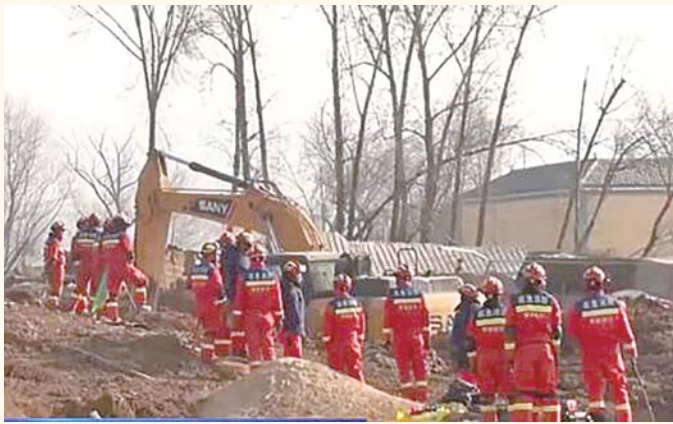
金田村救援现场。图据央视
