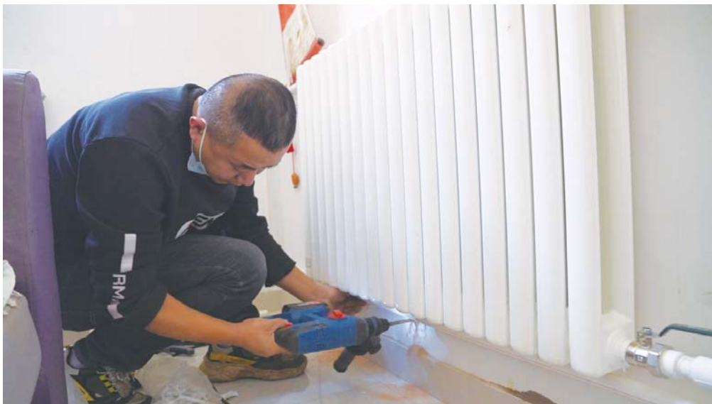
热力公司工作人员正在为林先生家加装暖气片。
