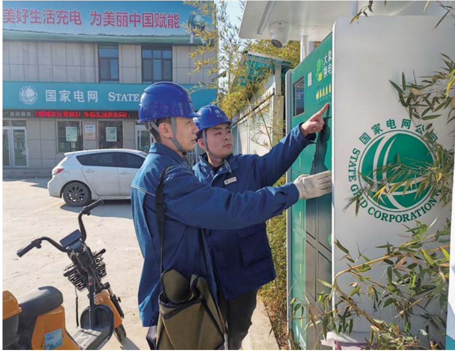
工作人员查看换电柜情况。姜倩 摄
