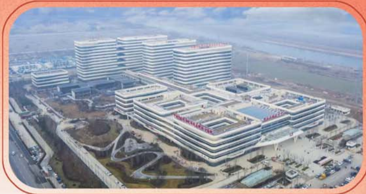
西苑医院济宁医院(济宁市中医院)新院区。
