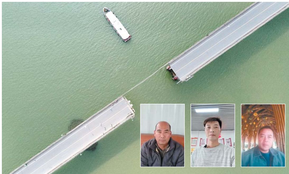
大图：2月22日无人机拍摄的沥心沙大桥事故现场。新华社发 小图从左到右：黄福林、王国梁、唐群辉 受访者供图
