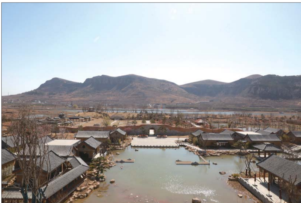
鲁源小镇项目核心区(二期)破土动工。
