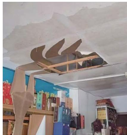
逢先生家的水管爆裂导致楼下四个门头房不同程度受损。
