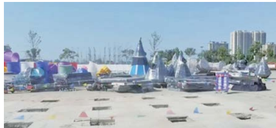
◀ 贝州湖公园部分区域正在施工。
