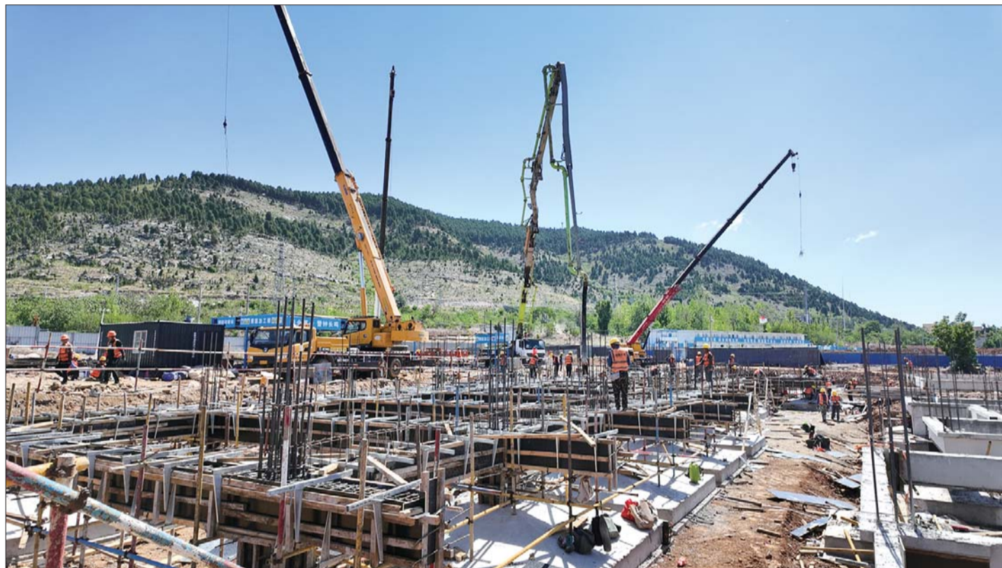
项目建设现场热火朝天。
