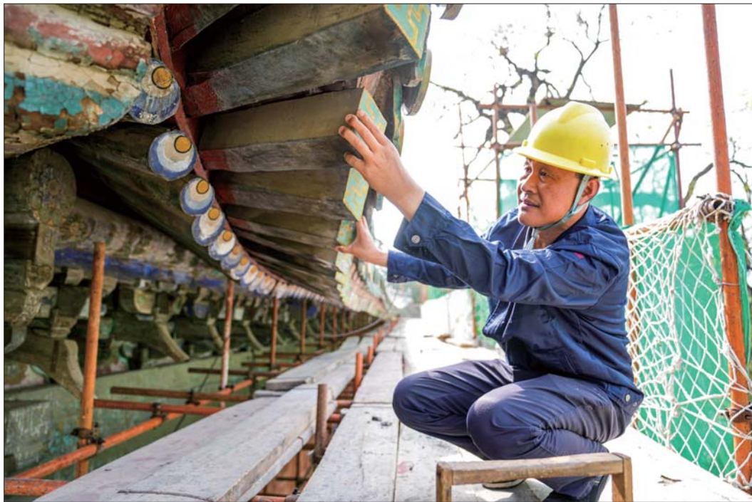
孔令伟检测圣迹殿的大架木构件。
