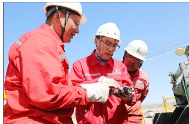
钻井施工中，地质人员密切关注油井岩性变化。
