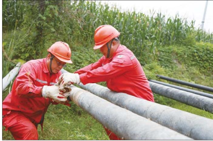
近日，在胜利油田鲁明公司济北采油管理区曲9-127计量点，员工正在修复过沟管线的保温层。据了解，为保证冬季生产平稳运行，这个管理区早打算、早计划，提前对全部设备、设施进行摸底排查，逐一检查抽油机设备、注采井网、高低压线路、变压器等，对设备的保温、包扎、覆土情况做了全面摸查，确保冬防保温工作做扎实、做到位。同时，管理区还完善冬季安全生产应急预案，让每名员工掌握冬防知识，为冬季安全生产打好基础。
