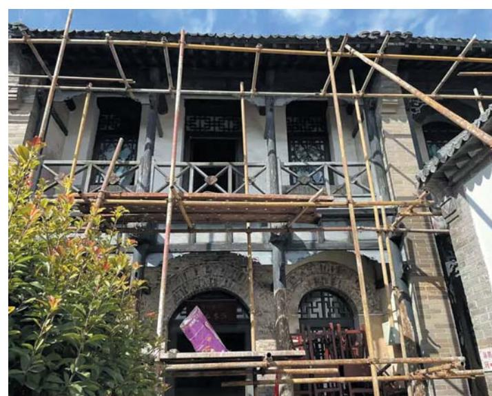
形制;墙体采用“挖补酥碱青砖”工艺修补室内墙面,重现青砖黛瓦风貌;木构架加固以传统榫卯修复为基础,叠加碳纤维加固技术,在保留古意的同时提升承重安全性。此外,环境整治同步推进,拆除遮挡古建的现代构筑物,疏通排水系统,恢复“四水归堂”传统排水格局。
