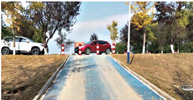
黄河堤顶道路两侧设置了路桩。
