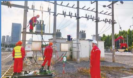
运维人员进行油井作业临时用电拆接电施工。 通讯员 姜微 摄
