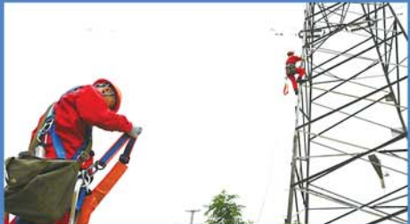
巡线人员检查安全带，做好登塔前的安全准备工作。 通讯员 陈晓燕 摄
