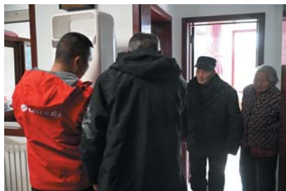
工人们正在给家里安装孙子给他们买的空调,老两口忍不住出来看一看。
