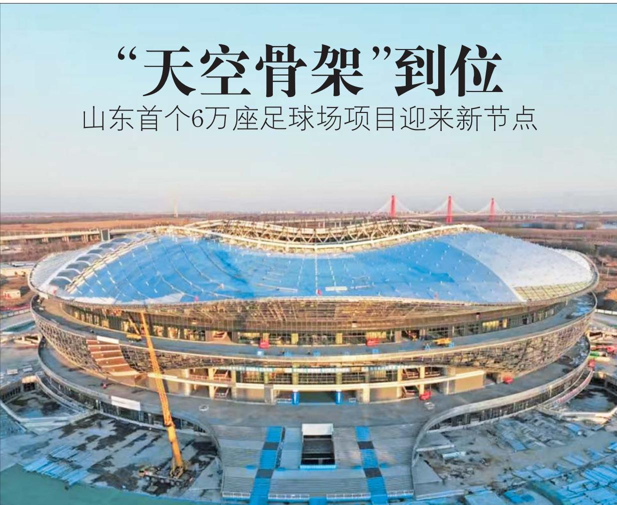
近日,随着最后一榀径向索桁架精准提升到位,济南黄河体育中心专业足球场的“天空骨架”——轮辐式索桁架体系完成吊装,标志着山东省首个6万座专业足球场的核心屋盖结构实现重大突破。
