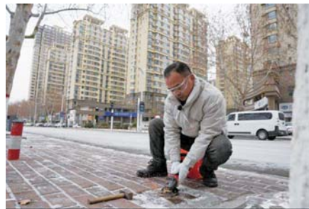
孙华国用角磨机把钉子一点点打磨平整。
