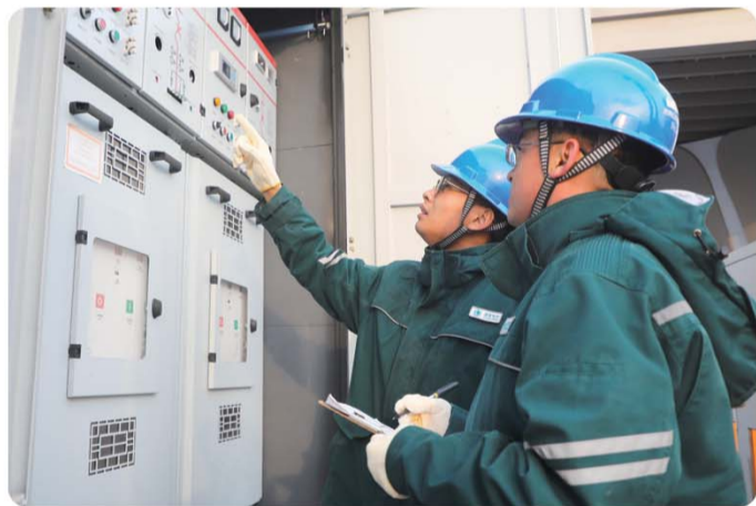
对车站附近重要供电线路进行检测。
