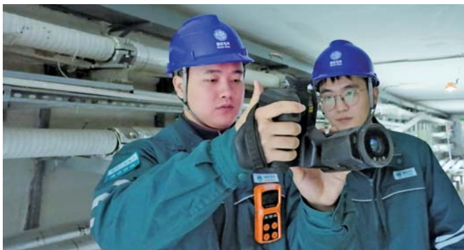
张朝阳(左)和王云龙在大明湖底巡检电缆。
