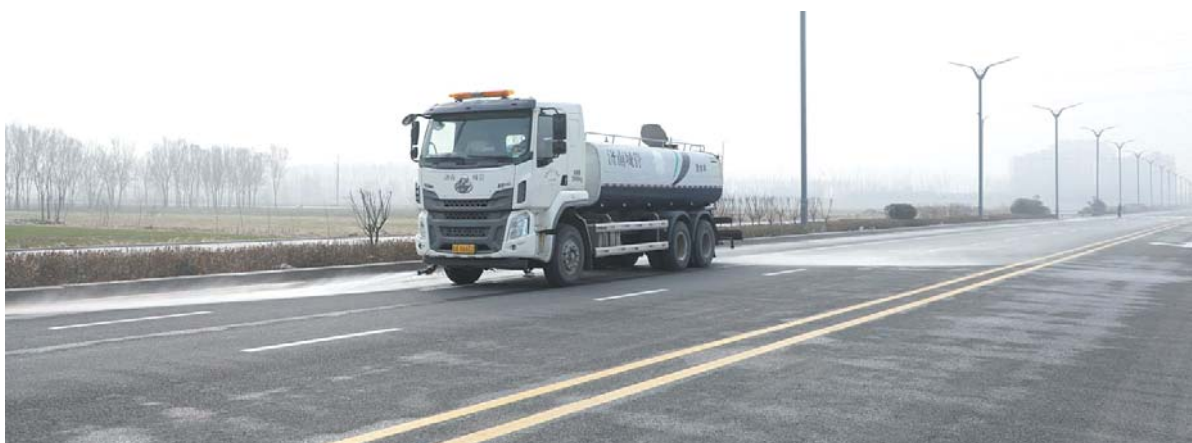
洒水车清除路面积尘。
