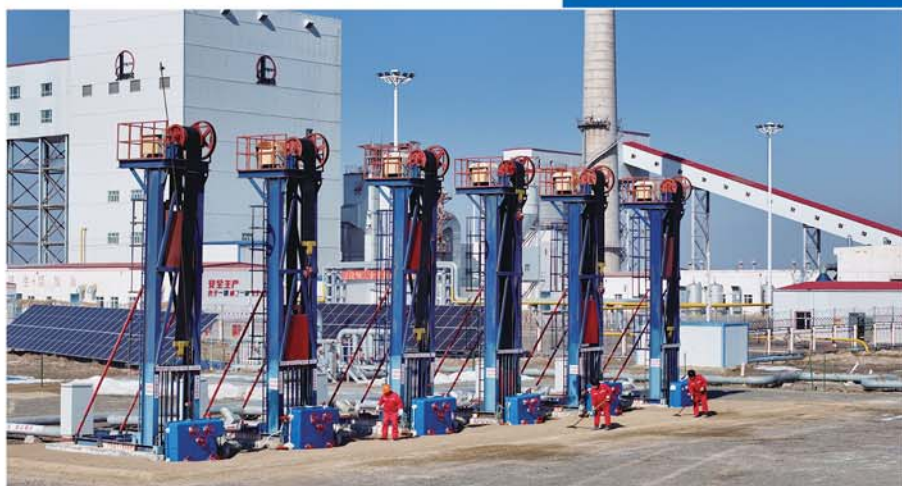
新春公司密切关注生产动态,夯实井场“三标建设”根基。
