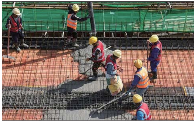
项目施工现场。
