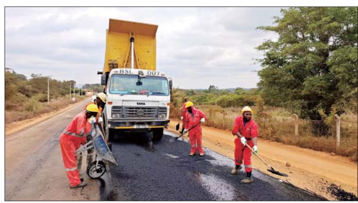
肯尼亚RWC道路工程施工现场。
