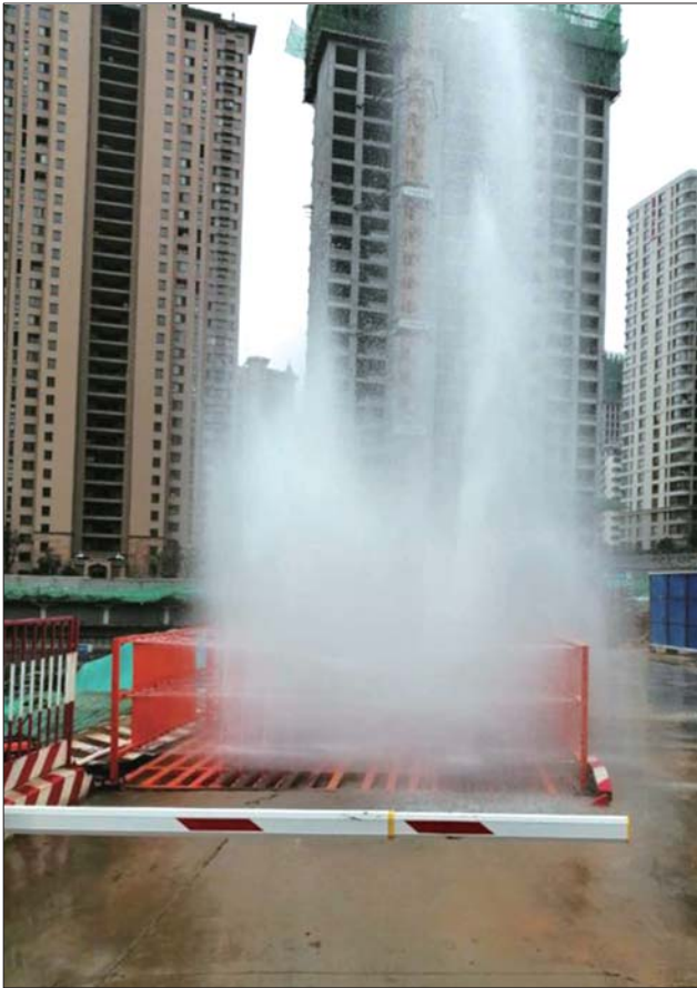
建筑施工扬尘防控。
