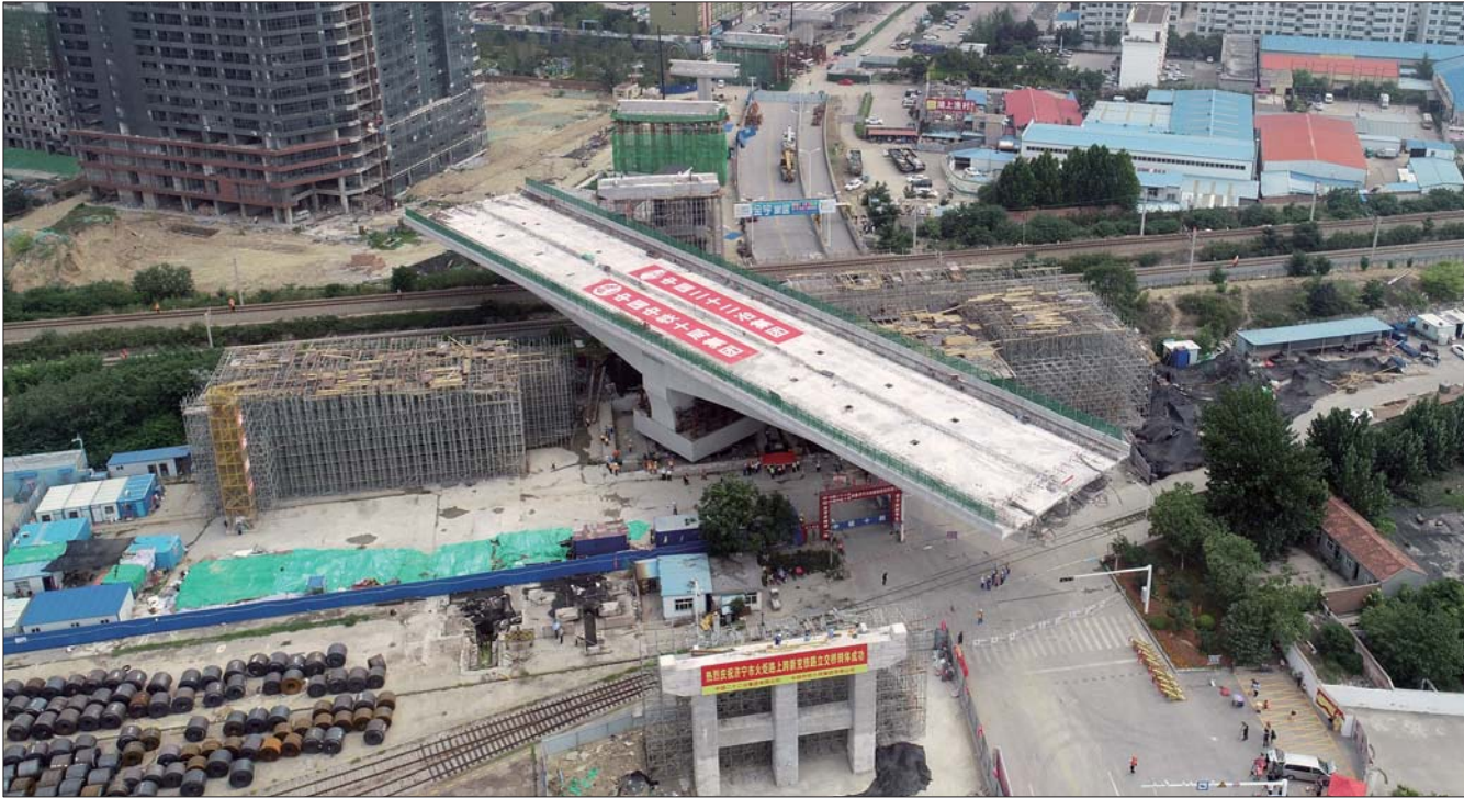
火炬路跨线桥转体梁正在转体。 齐鲁晚报·齐鲁壹点记者 孙逢辉 摄
