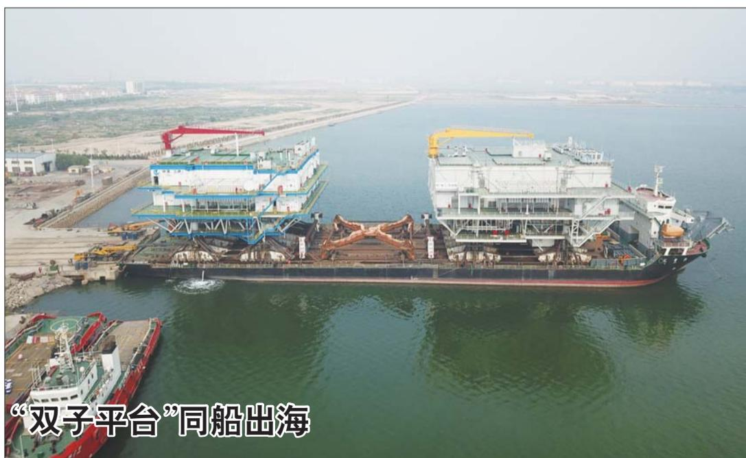
近日,胜利油建公司承建的三峡阳江海上风电项目220KV海上升压站上部组块和中广核南鹏岛海上升压站上部组块,在25吨卷扬机及滑轮组的牵引下缓缓移向汇宗海号自航驳船,标志着中广核及三峡阳江项目陆地安装工作全部结束,进入海上施工阶段。面对技术要求高、施工难度大、工作任务重等诸多挑战,胜利油建公司成立技术专班,科学制定两座大型平台同船出海的作业方案,通过全过程管控等举措,历经四天四夜最终优质高效完成滑移装船任务。本报记者 崔立慧 通讯员 王明月 张鸿飞 摄影报道
