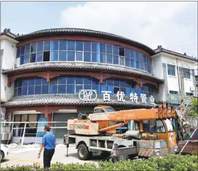
现场拆除户外广告牌。
