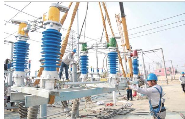
端支柱绝缘子更换和174根引线改造工作。
