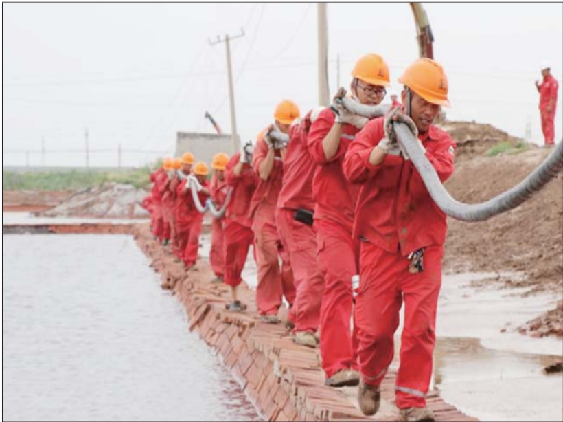
电力员工人工敷设电力电缆。
