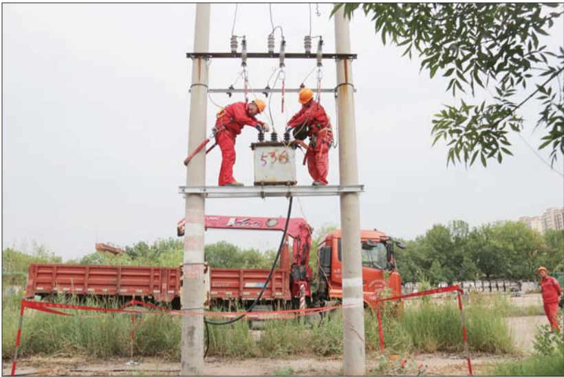
员工更换高耗能变压器。
