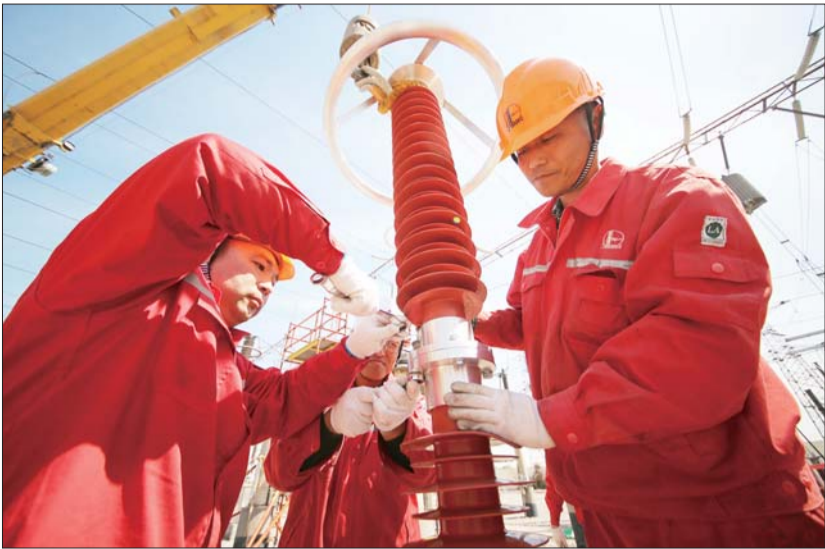
员工在220千伏九分场变电站更换避雷器。
