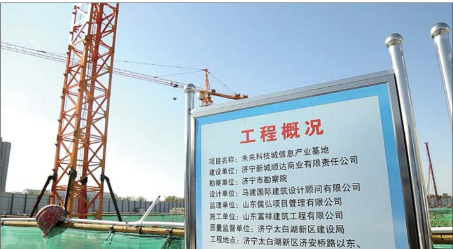
未来科技城部分地面基础已完成,预计2021年底竣工。
