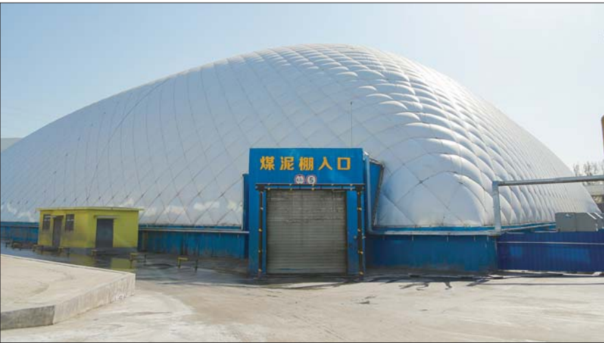
两层充气膜建设的煤泥棚。
