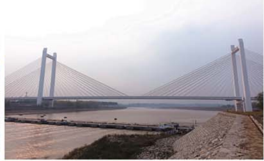
农发行山东省分行基金投资支持的齐河县黄河公路大桥项目
