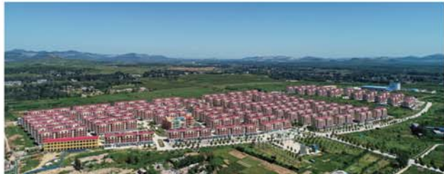
农发行山东省分行贷款支持的东平湖库区移民避险工程凤凰社区项目
