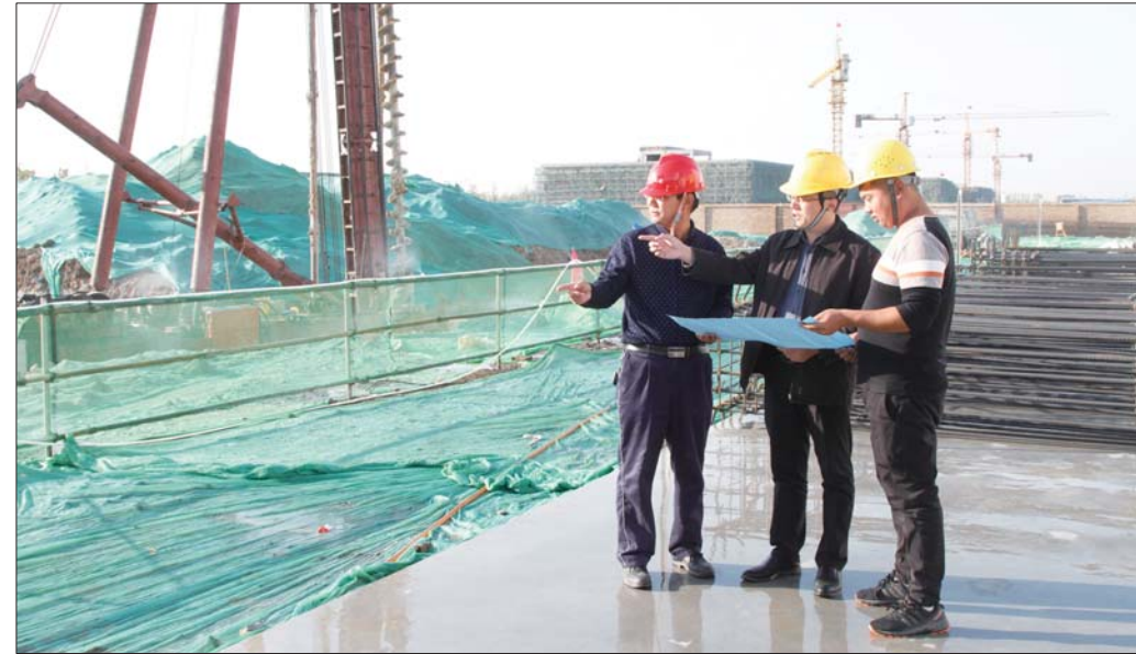
华东新型墙体材料项目建设顺利推进中。
