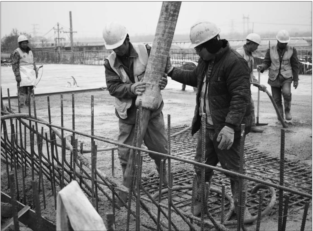
中铁十四局的工人正在工地上进行浇梁施工。 齐鲁晚报·齐鲁壹点 记者 朱贵银 摄
