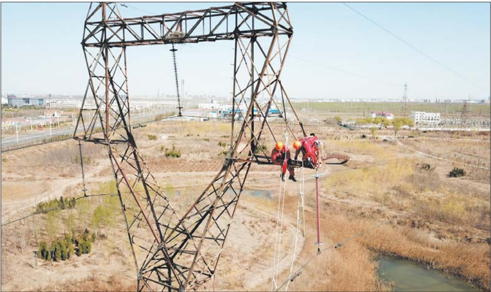
员工正在更换绝缘子。
