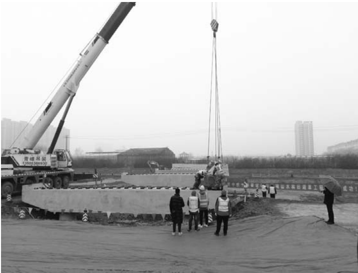
泰山山水林田湖草工程完成第一梁架设 本报记者 王瑞超 摄
