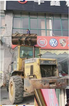
拆除违规广告牌
