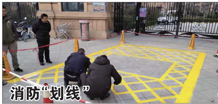
消防“划线” 为推动有效解决占用、堵塞消防通道“老大难”问题,连日来,德城区消防救援大队辖区各物业单位按照消防车通道设置相关要求,陆续开展消防通道的划线工作。齐鲁晚报·齐鲁壹点记者 贺莹莹 通讯员 李恺 摄影报道
