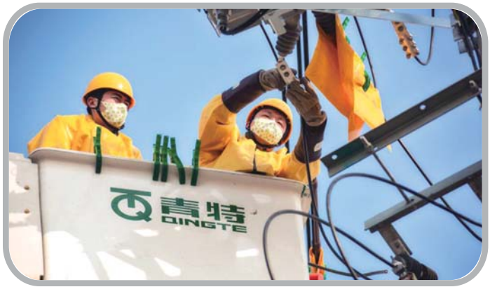
工作人员进行带电接火送电。
