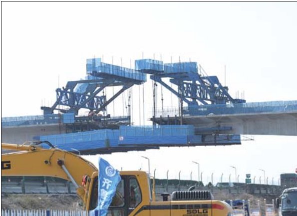
平邑互通立交正在跨越日兰高速。 通讯员 蒋龙龙 摄
