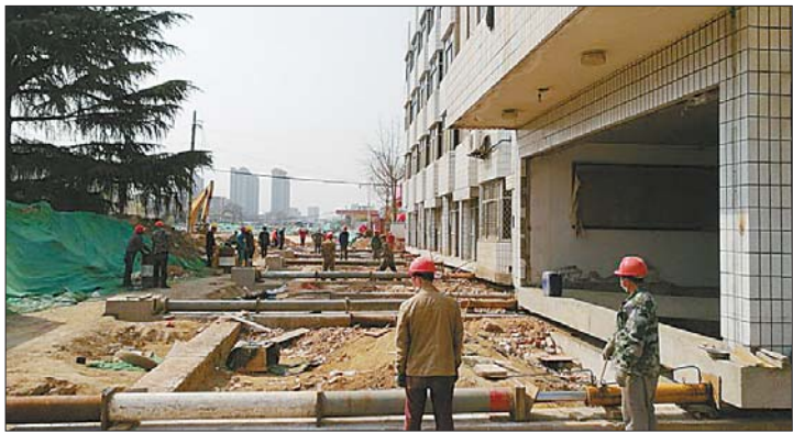
在工作人员操控下,大楼成功平移6米。 齐鲁晚报·齐鲁壹点记者 张泽文 郭健 摄
