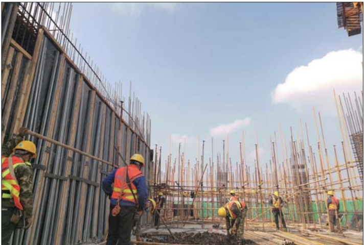
枣庄市双子星城市广场A区续建工程,热火朝天复工忙。 通讯员 马耀坤 摄
