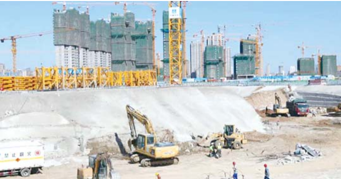
日照奎山体育中心工地一片忙碌
