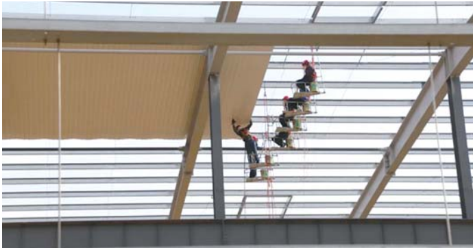
日照威突整车项目车间正在建设 刘涛 摄
