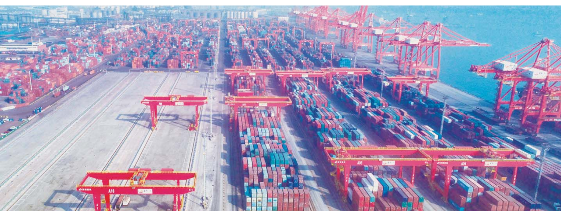
山东港口日照港集装箱三期改造工程
