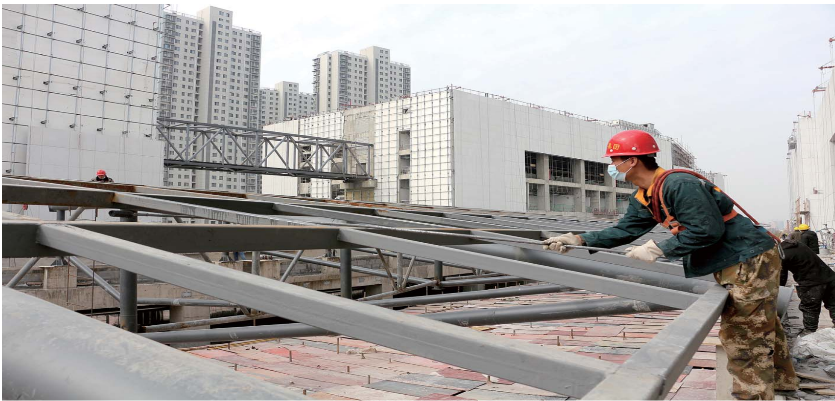
菏泽市民文化中心项目复工现场。
