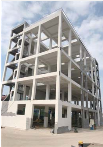
正在建设的3000t/d高盐废水治理项目。
